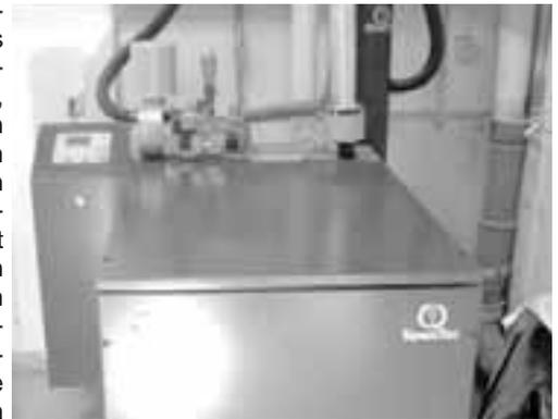
aus dem integrierten 1000 Liter Pufferspeicher, der als sogenannte hydraulische Weiche dient.
