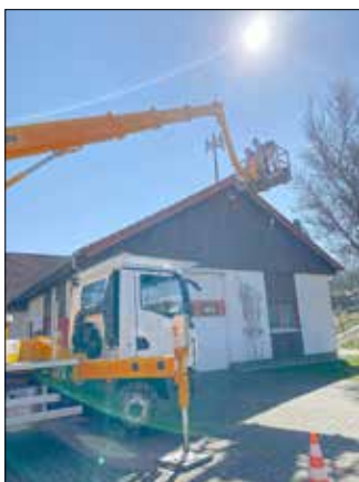
Per Hubsteiger wurden die neuen Sirenen von einer Fachfirma – hier in Hertingshausen – montiert. (Foto: Gemeinde Wohratal)
