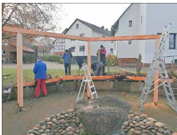
Mit gemeinsamer Tatkraft wird die neue Konstruktion der Pergola montiert. (Foto: R. Wasmuth)
